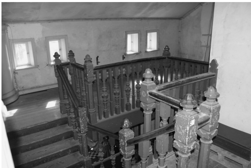
Abb. 2: Treppenhaus (Foto: Andreas Zopff)
