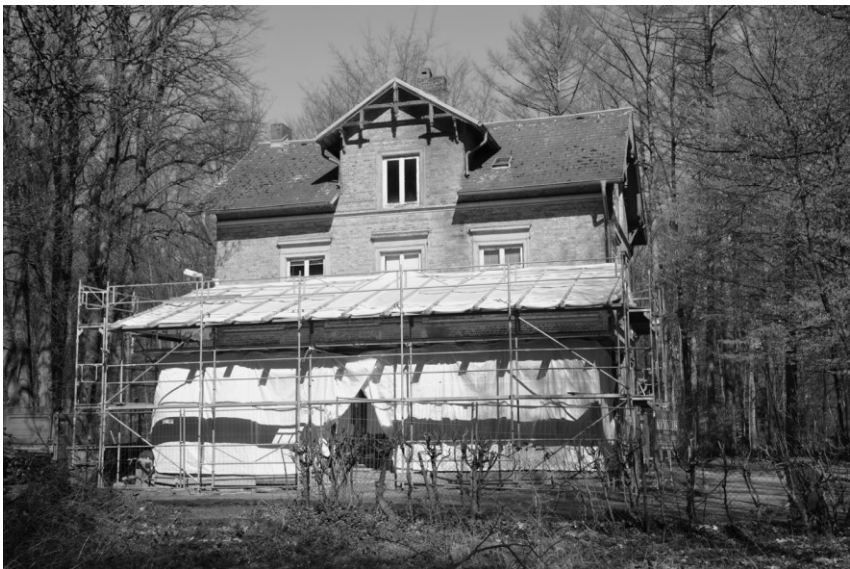
Abb. 3: Wetterschutzdach Verandasanierung (Foto: Andreas Zopff)
