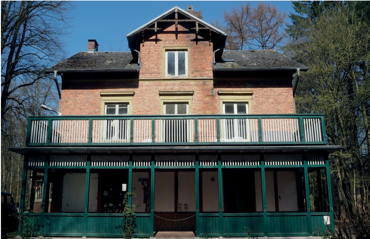
Ort der Malerarbeiten: Die Villa Mutzenbecher
