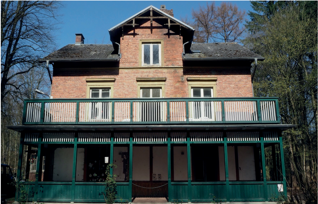
Ort der Malerarbeiten: Die Villa Mutzenbecher
