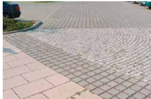
Platten sowie Sicker- und Kleinpflaster
