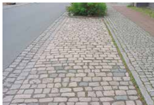
Gepflasterter Parkstreifen an einer Anliegerstraße
