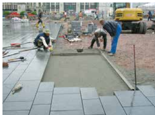
Die Bettung wird abgezogen (hier Betonbettung)
