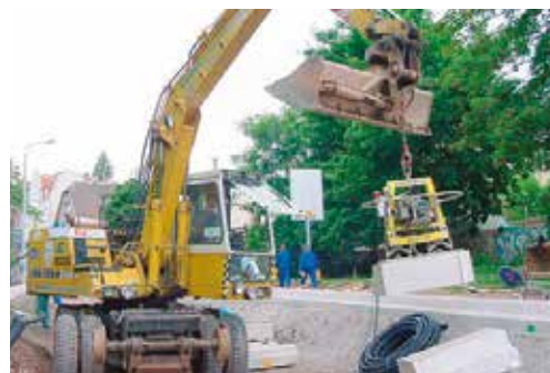
Vakuumhebergerät am Bagger
