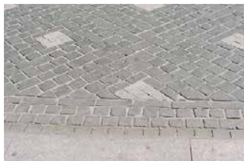
Basaltpflaster mit Fugenvermörtelung
