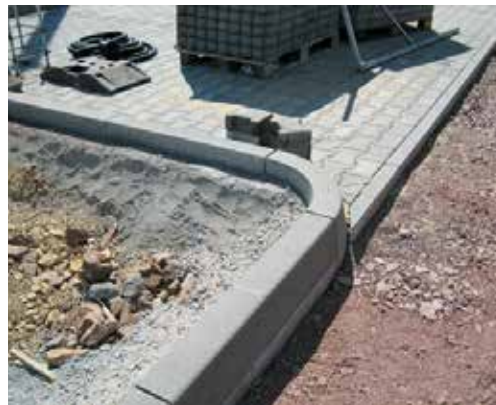
Randbefestigungen werden zuerst gesetzt
