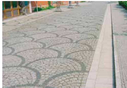
Schuppenverlegung (Schuppenverband)
