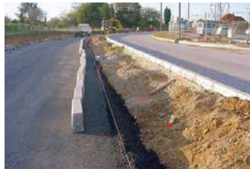
Bordsteine, zum Verlegen auf Asphalttragschicht bereitgelegt
