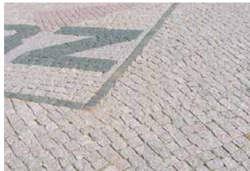
Netzverband mit sehr maßgenauen Steinen; dabei ist eine bogenförmige Randanbindung kaum möglich
