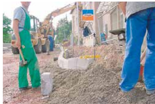
Versetzen der Bordsteine nach Schnur
