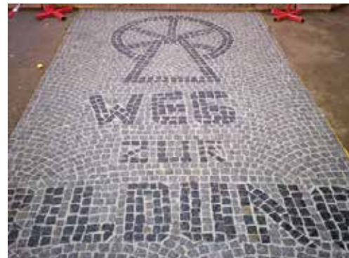
Fachmännisch ausgeführte Pflasterfläche
