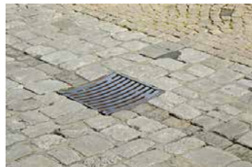
Tieferliegende Rinne zur Wasserführung
