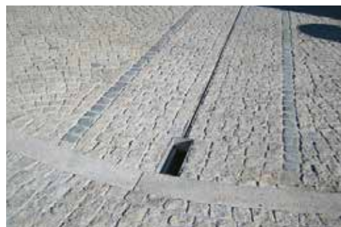
Sauber gebundene Natursteinpflasterung mit Rinne
