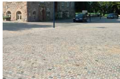
Reihenverband mit Fugenmörtel
