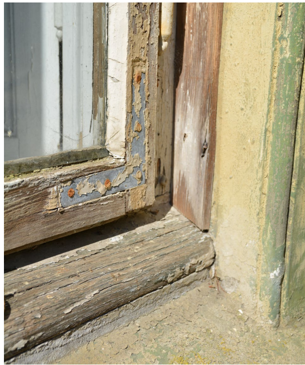
Von außen sind bei vielen Fenstern die deutlichen Spuren der Witterungseinflüsse und der mangelnden Pflege sichtbar.
