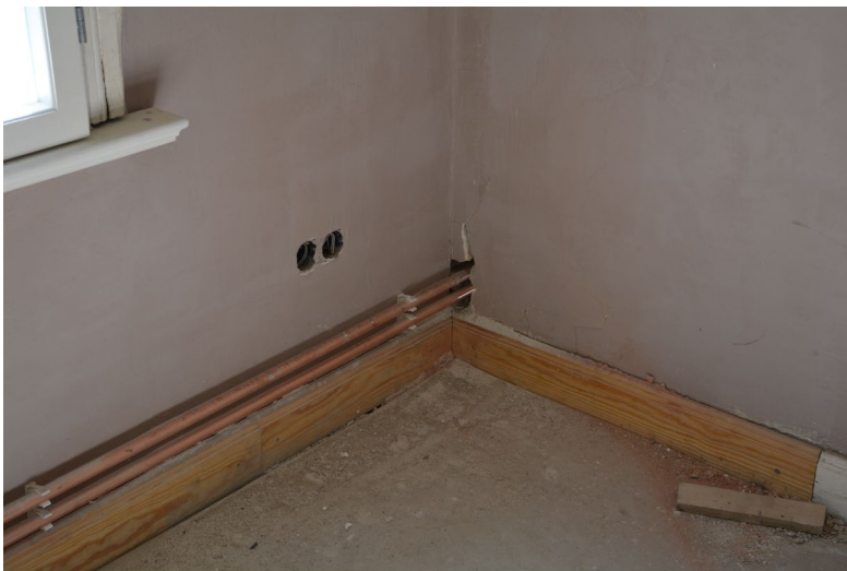
Die Rohrleitungen zu den Heizkörpern wurden sichtbar über den Fußleisten verlegt. An wenigen Stellen mussten – wie hier im Bereich der Terrassentür im 1. Obergeschoss – kreative Lösungen gefunden werden.
