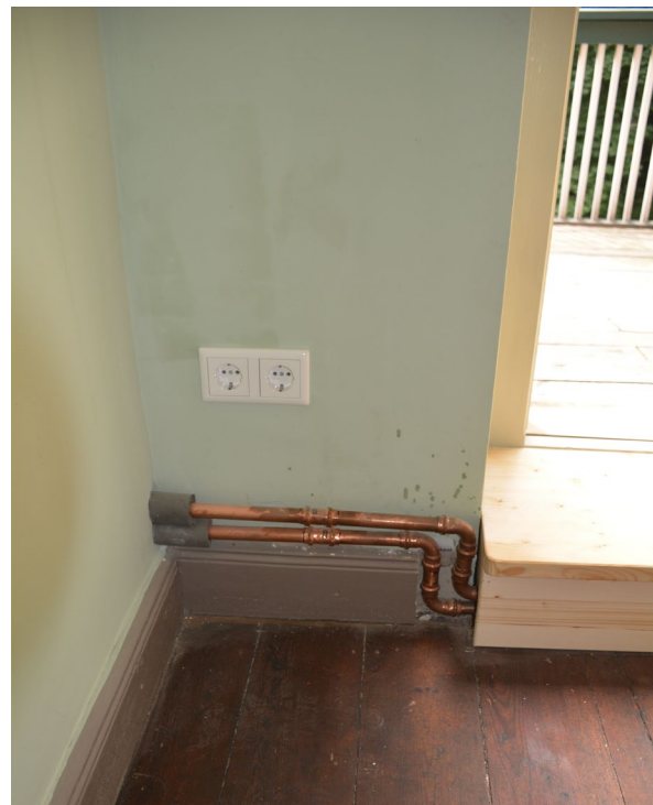
Die Rohrleitungen zu den Heizkörpern wurden sichtbar über den Fußleisten verlegt. An wenigen Stellen mussten – wie hier im Bereich der Terrassentür im 1. Obergeschoss – kreative Lösungen gefunden werden.
