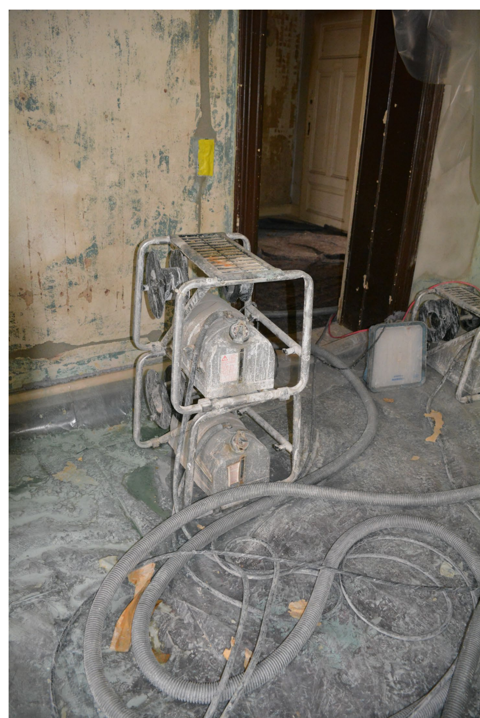
Die Altanstriche wurden maschinell abgewaschen.
