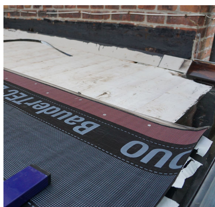
Abdichtung des Verandadachs und Herstellung des Übergangs zum Mauerwerks.
