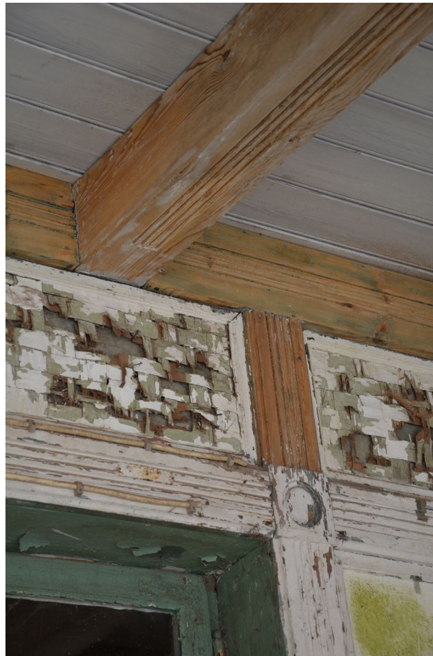
Die Rückwand der Veranda besteht aus Vertäfelungen im unteren Bereich und Holzgeflecht im oberen Bereich
