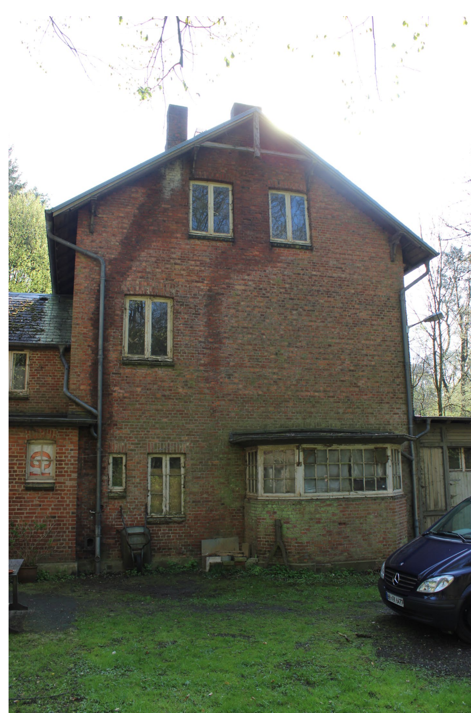
An den Schornsteinen sind deutliche Spuren einer Versottung zu erkennen.
