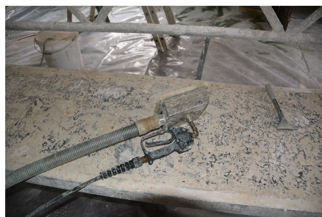
Die Altanstriche wurden maschinell abgewaschen.
