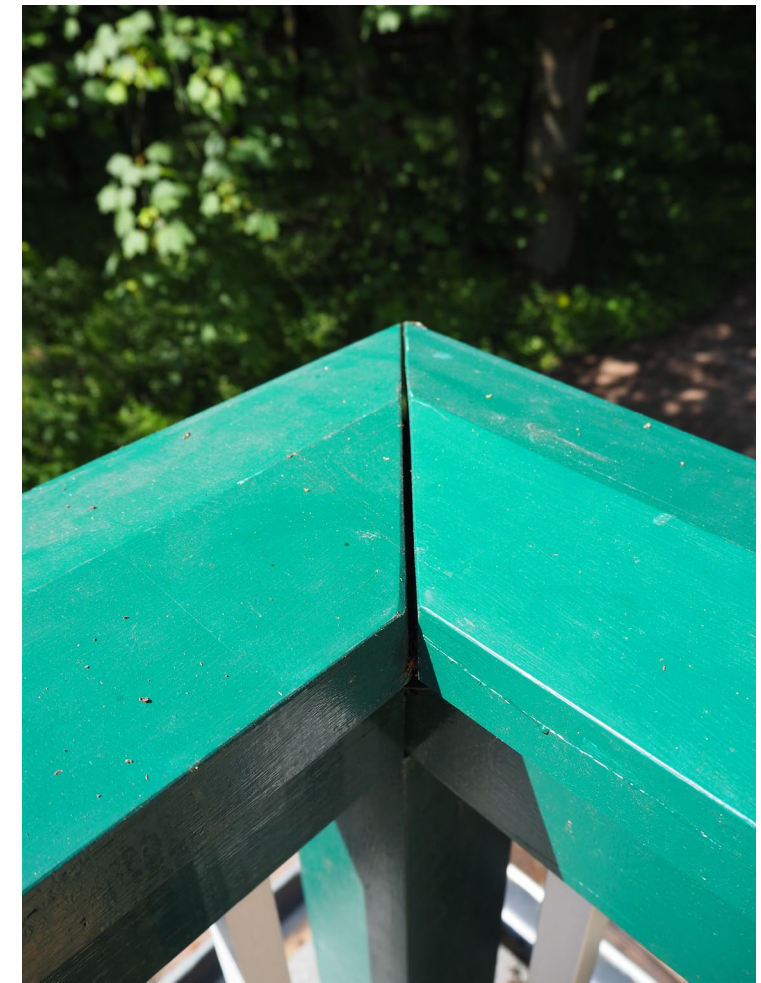
Das Geländer der Veranda wurde nach historischen Vorlagen neu erstellt. Verstärkungen aus Metall wurden gemäß aktueller Sicherheitsvorschriften ergänzt
