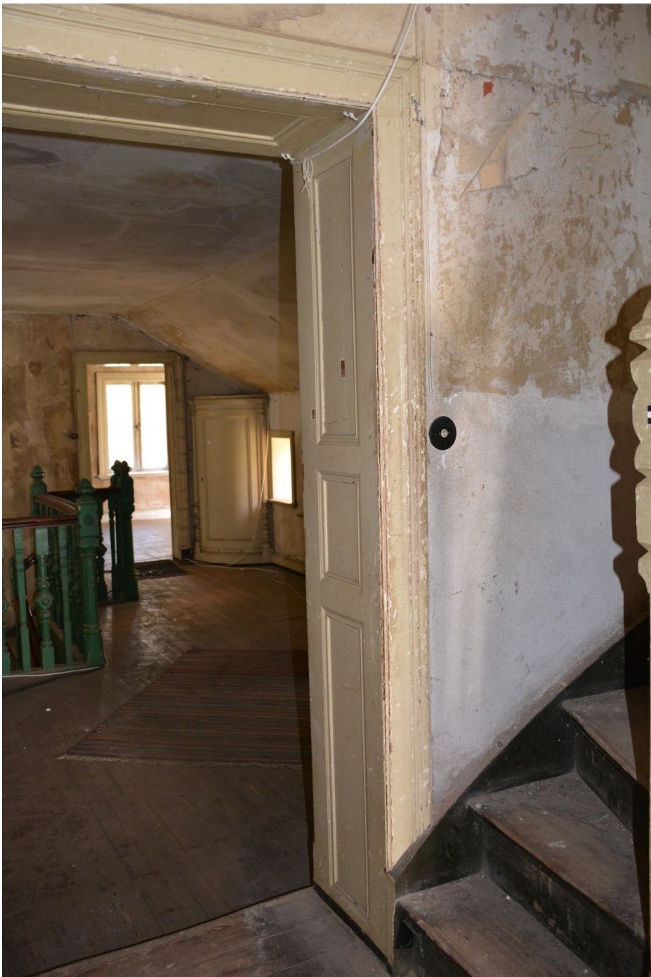
Im Flur und Treppenhausbereich des 1. Obergeschosses befindet sich ein aufwändig gestaltetes Durchgangsfutter
