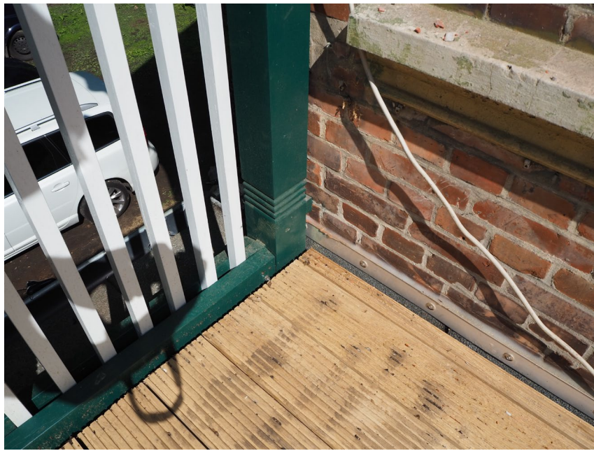
Das Geländer der Veranda wurde nach historischen Vorlagen neu erstellt. Verstärkungen aus Metall wurden gemäß aktueller Sicherheitsvorschriften ergänzt
