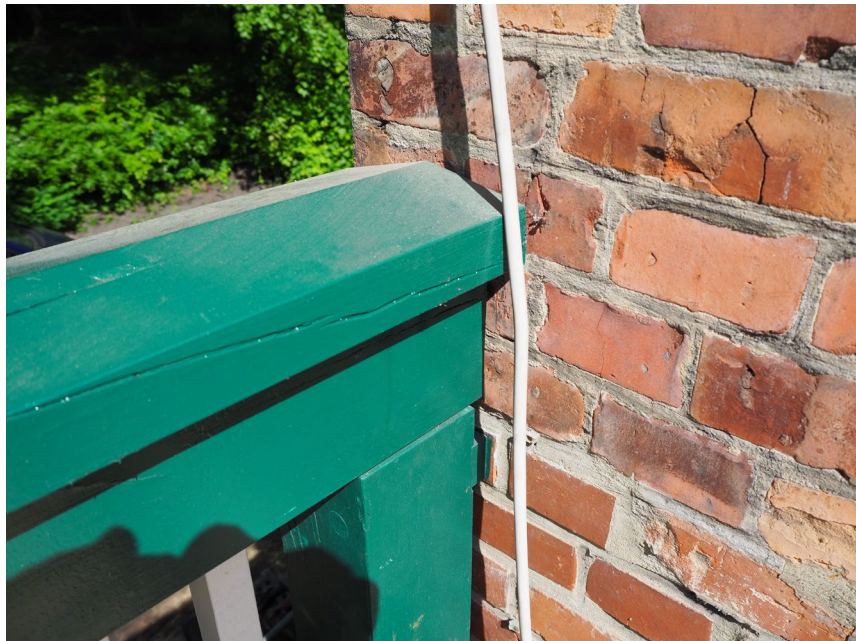
Das Geländer der Veranda wurde nach historischen Vorlagen neu erstellt. Verstärkungen aus Metall wurden gemäß aktueller Sicherheitsvorschriften ergänzt
