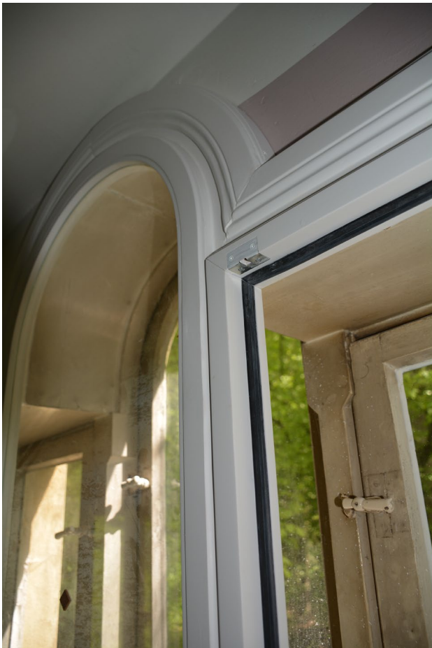
Die Konstruktion der Kastendoppelfenster für das Venezianische Fenster stellen eine besondere Herausforderung im mittleren Fenster dar.
