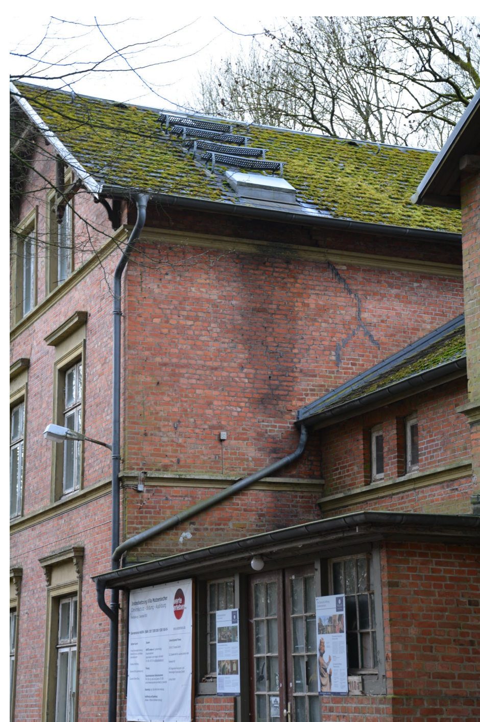
An den Schornsteinen sind deutliche Spuren einer Versottung zu erkennen.
