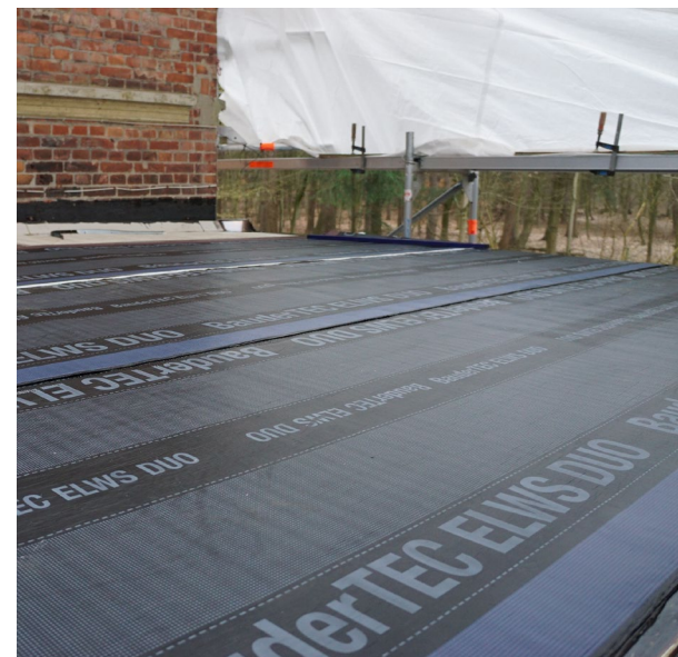
Abdichtung des Verandadachs und Herstellung des Übergangs zum Mauerwerks.
