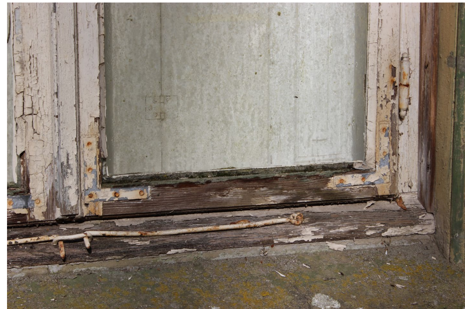
Von außen sind bei vielen Fenstern die deutlichen Spuren der Witterungseinflüsse und der mangelnden Pflege sichtbar.
