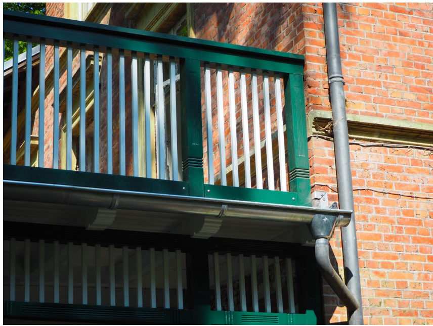
Das Geländer der Veranda wurde nach historischen Vorlagen neu erstellt. Verstärkungen aus Metall wurden gemäß aktueller Sicherheitsvorschriften ergänzt
