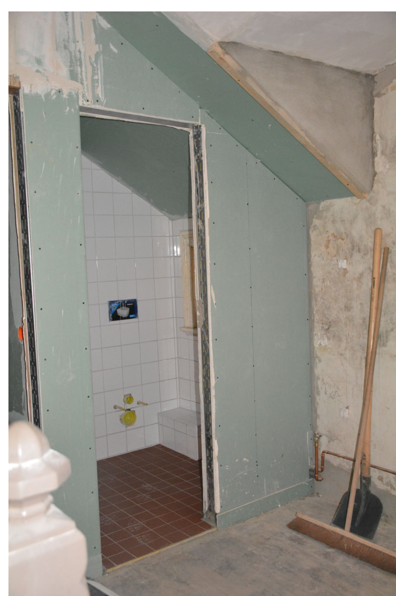
An der Stelle des alten Badezimmers konnten die Räume des WCs in Trockenbauweise errichtet werden
