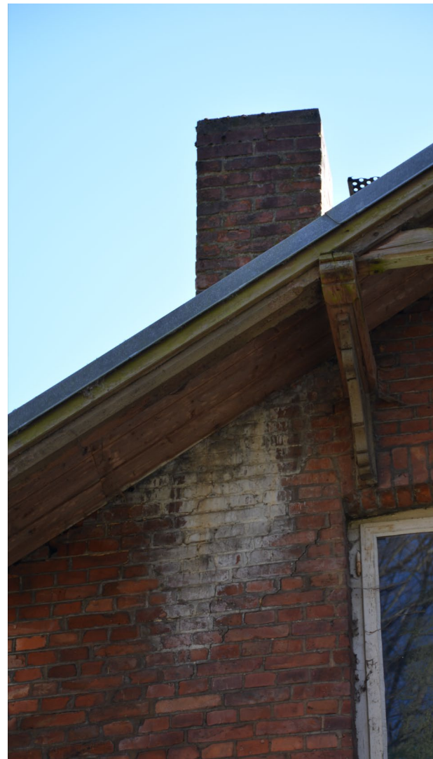
An den Schornsteinen sind deutliche Spuren einer Versottung zu erkennen.
