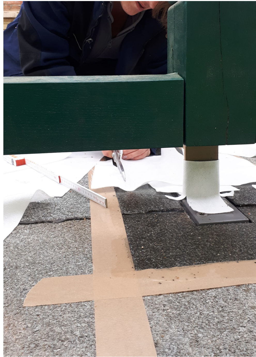
Eindichten der Geländerverankerung
