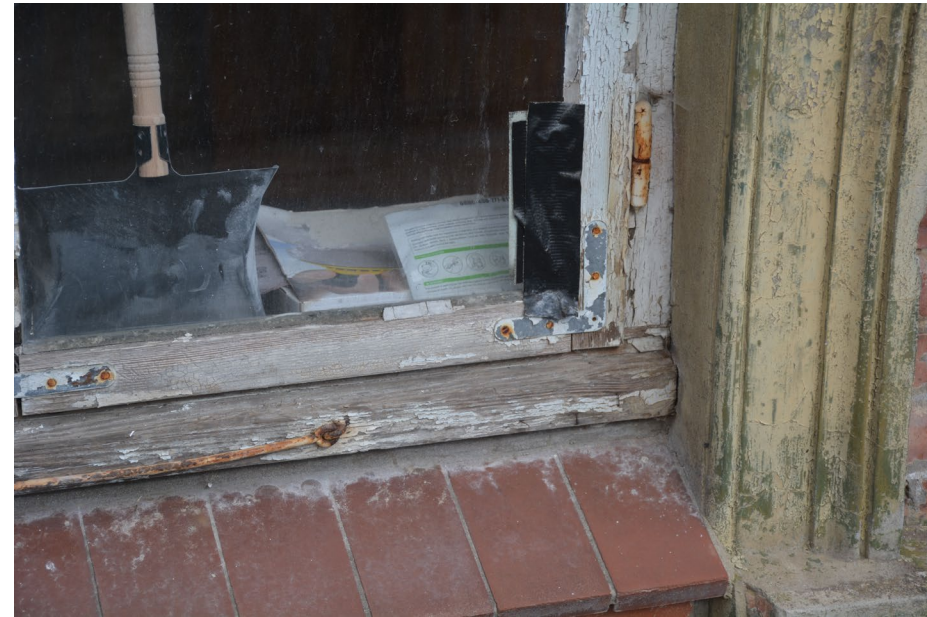
Von außen sind bei vielen Fenstern die deutlichen Spuren der Witterungseinflüsse und der mangelnden Pflege sichtbar.
